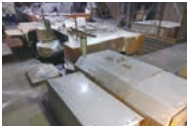
安全カバー施工状態
