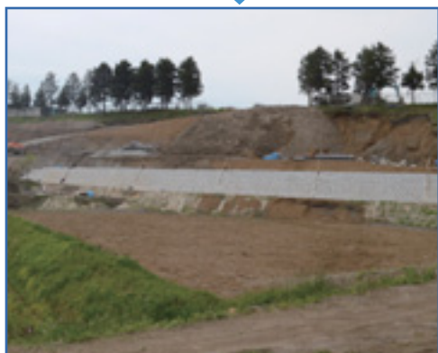
法面の復旧状況(平成24年7月頃、完成予定)
